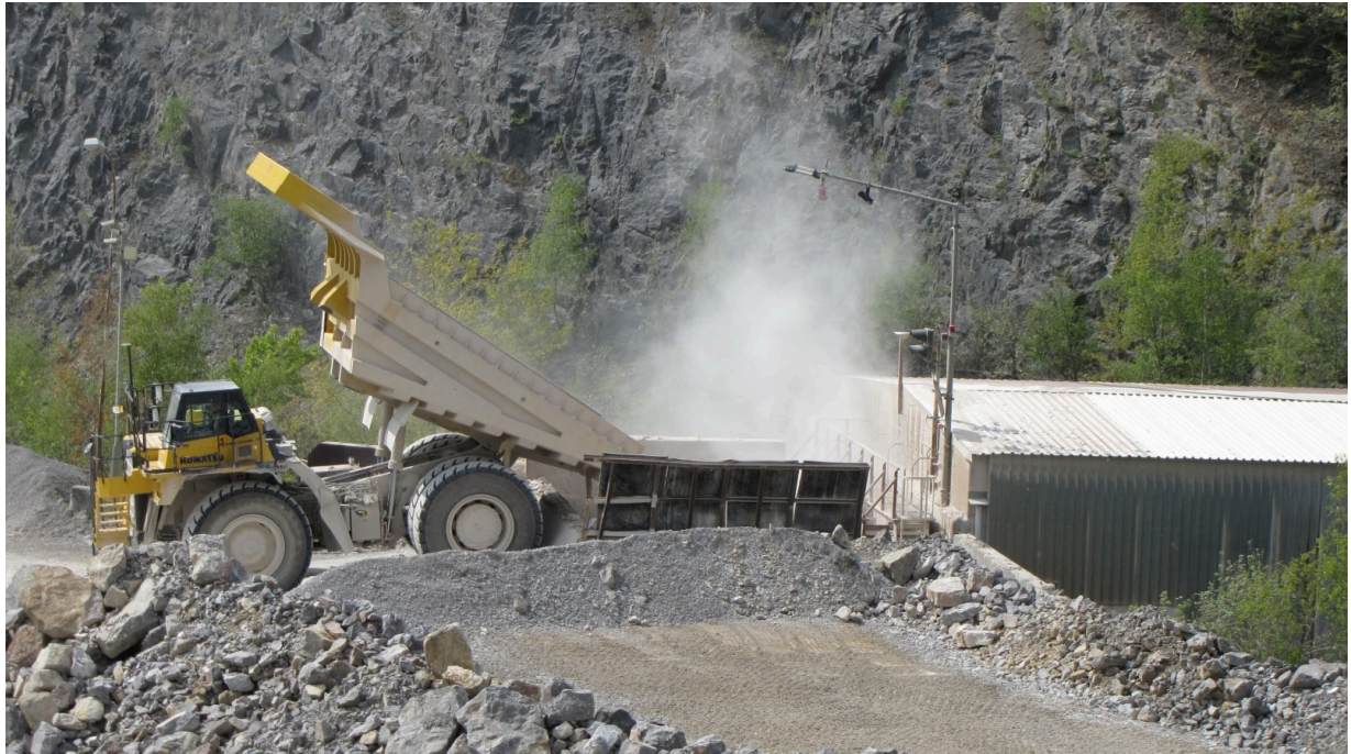
Arbeiten im Lhoist-Steinbruch im Hönnetal
